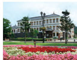
小坂鉱山事務所
